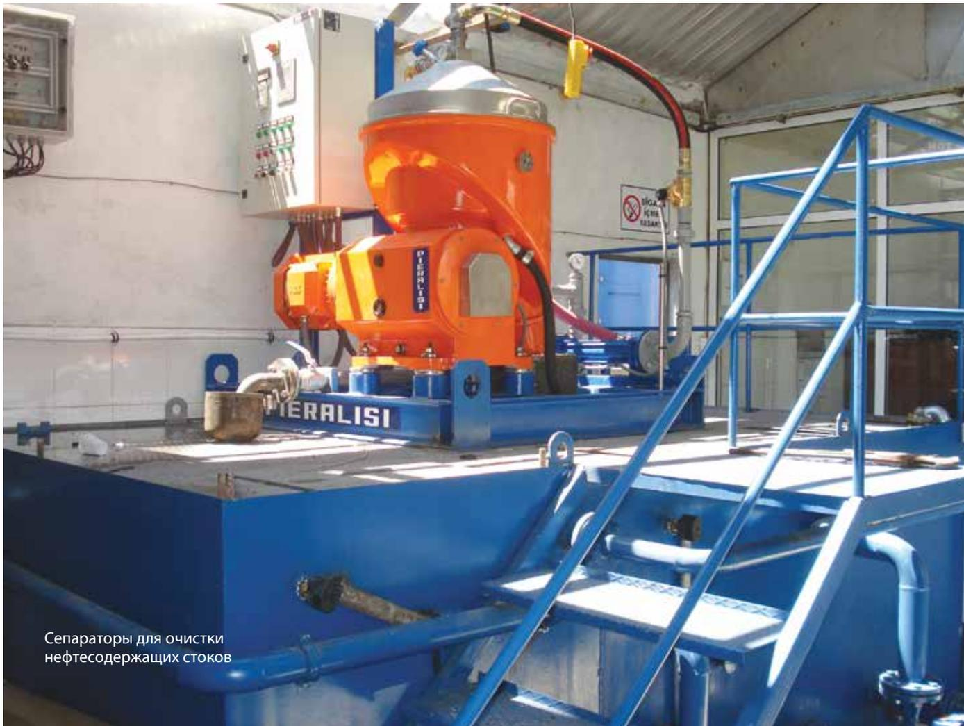
Сепараторы для очистки нефтесодержащих стоков
