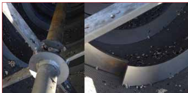
Фото 7. Примеси, задержанные на внутренней поверхности барабана решетки
