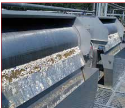
Фото 1. Барабанная решетка с внешней подачей сточных вод
