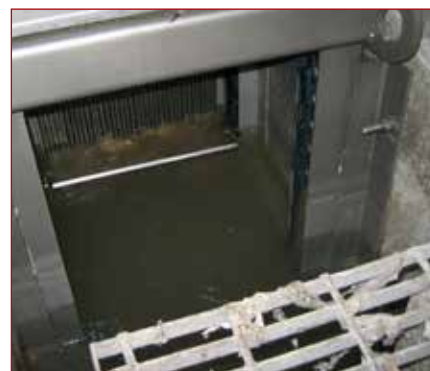
Фото 3. Механическая решетка грабельного типа
